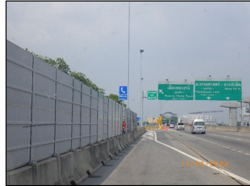
รูปที่ 2-12 กำแพงกันเสียงทิศตะวันออกจากทางด่วน บริเวณเอสซีจีสเตเดียม เป็นระยะทาง 250 เมตร
